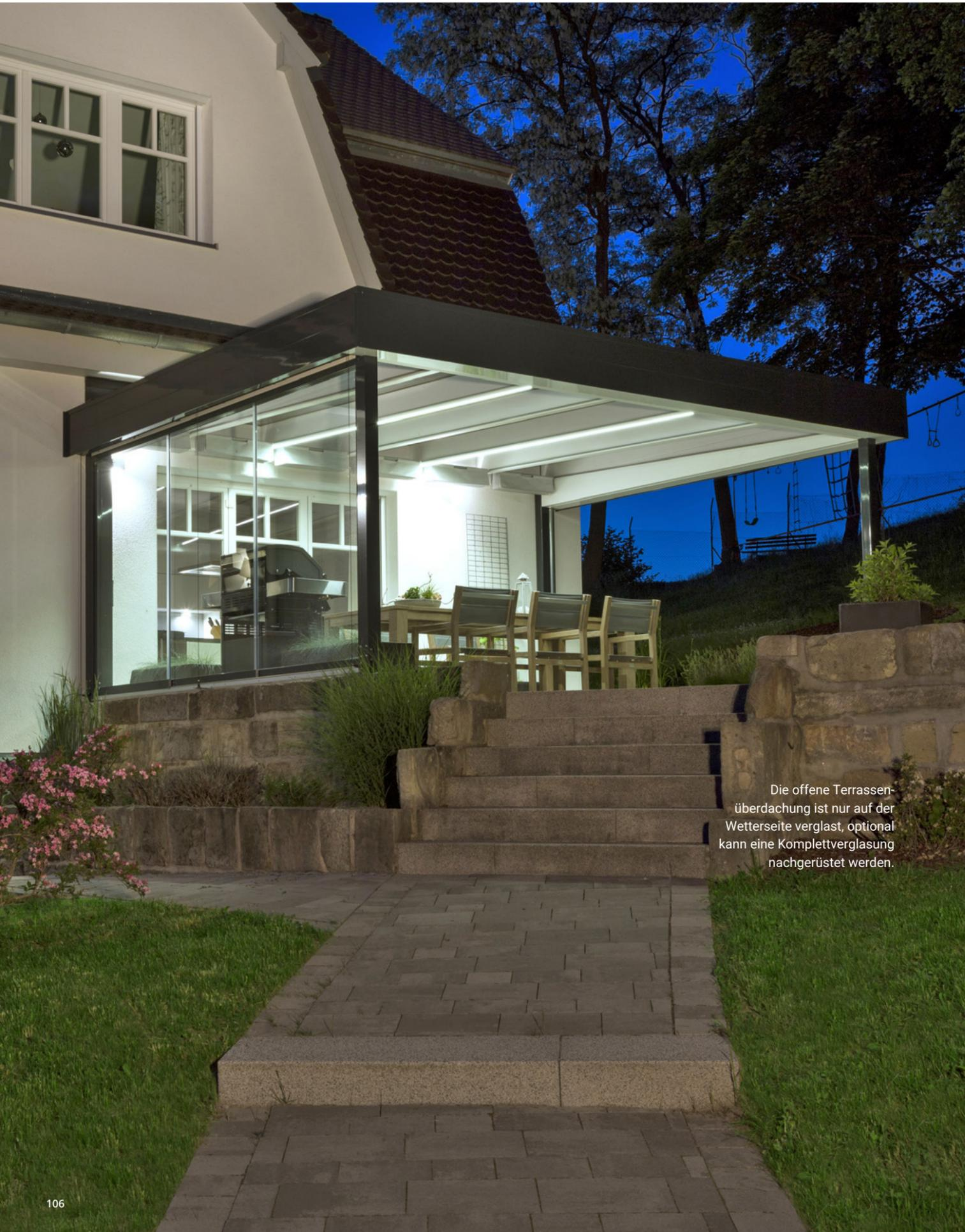
Die offene Terrassenüberdachung ist nur auf der Wetterseite verglast, optional kann eine Kompletterverglasung nachgerüstet werden.
